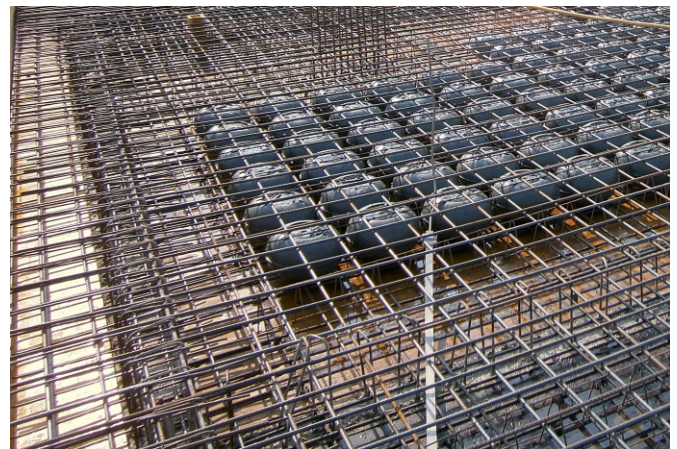
Fig. 5 Accomplishment of a constructive solid zone Ausführung eines konstruktiven Randstreifens
