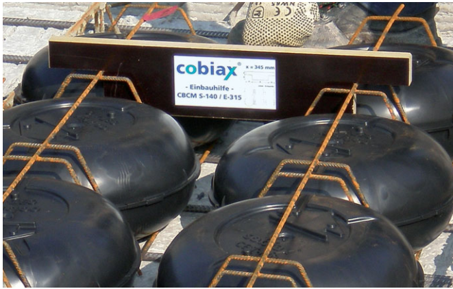
Fig. 2 Template to assure axis-centre distance Anwendung einer Einbauhilfe für die Sicherstellung des Achs- abstandes
